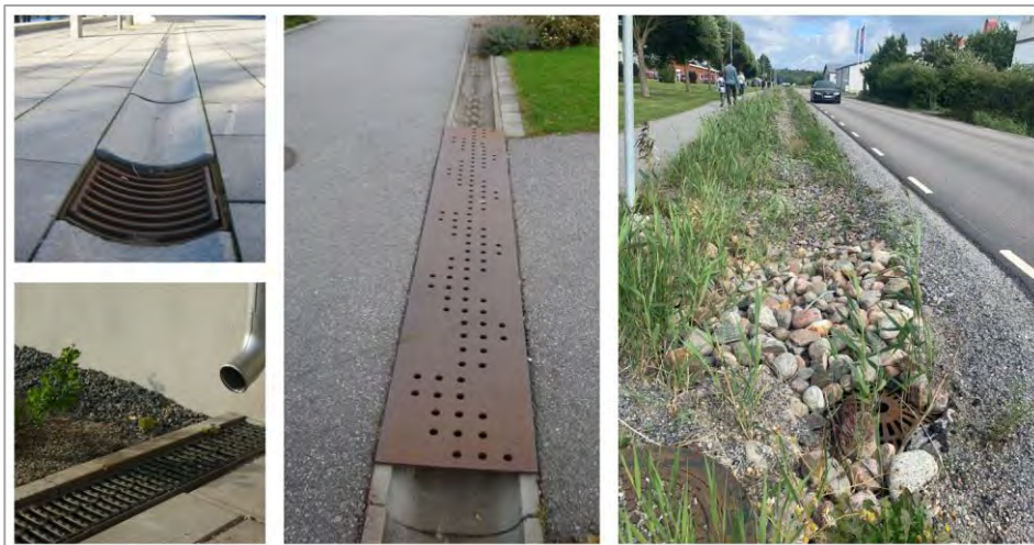
Figur 5-4. Exempel på diken och rännor. Bildkälla: Sweco
